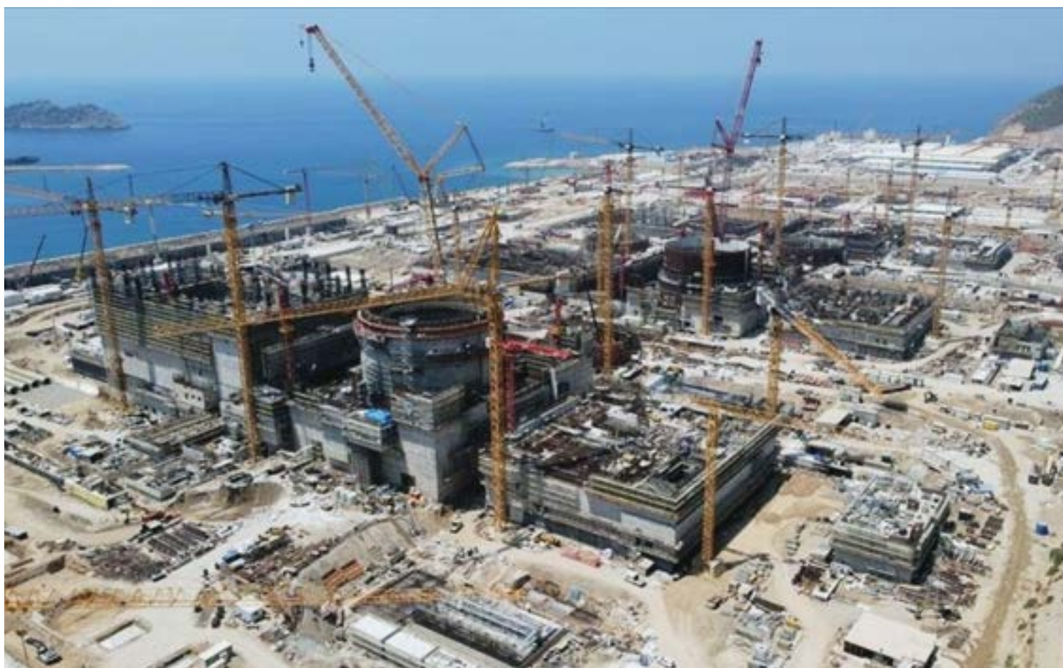
Průběh výstavby JE Akkuyu
