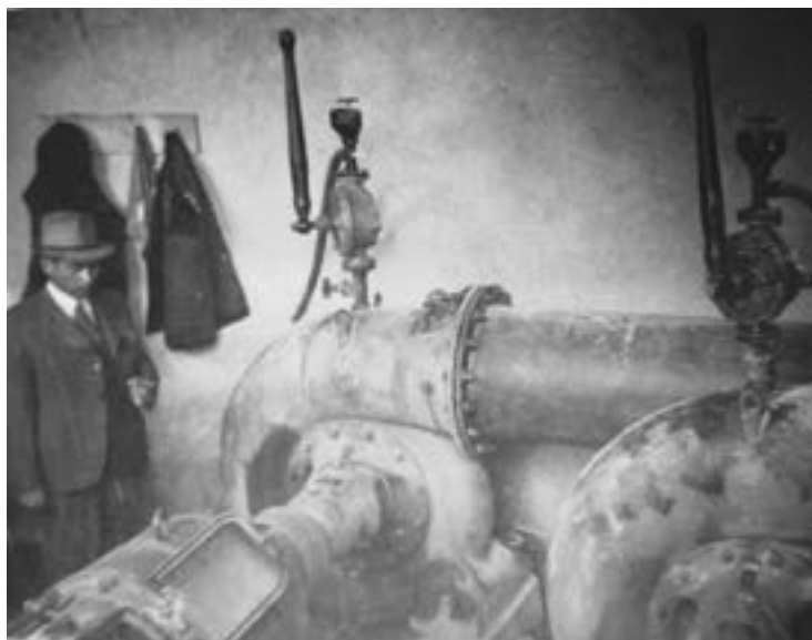
Montáž stanice „Tundža“
