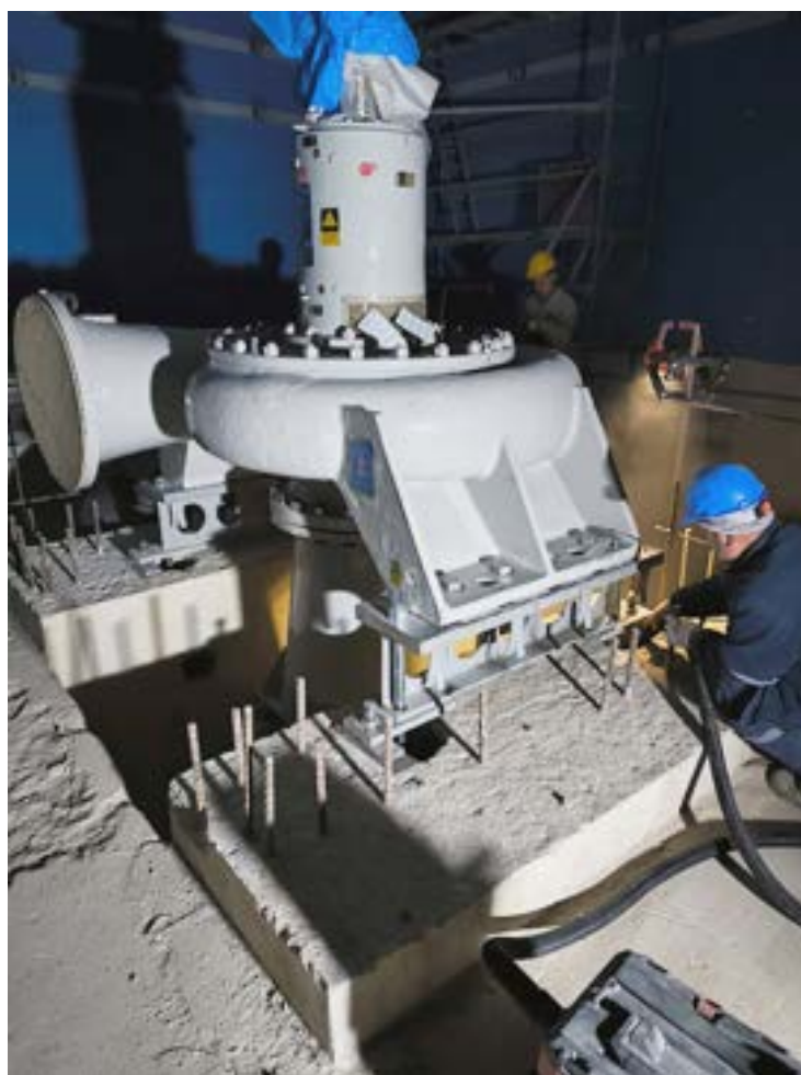
Usazení čerpadla na pozici
