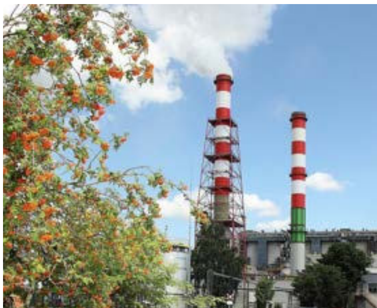
1 Pohled na elektrárnu ještě bez odsiřovací jednotky, jejíž realizace končila s lehkým časovým předstihem modernizace chladicího okruhu
