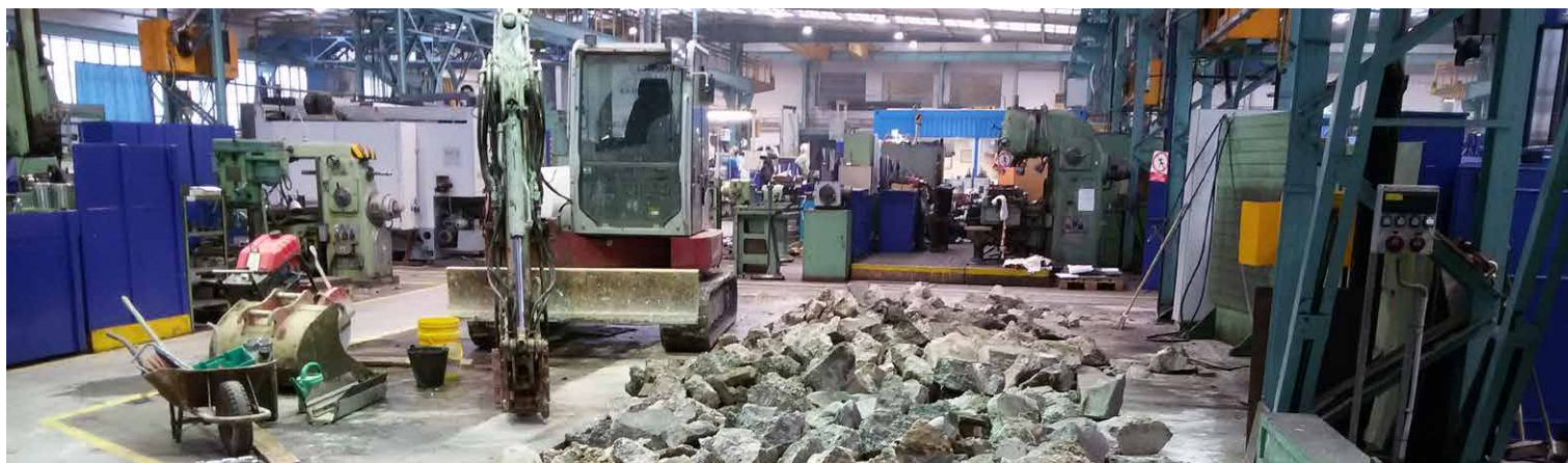
1 Realizace základu pro nový CNC soustruh s točnou délkou 6000 mm
