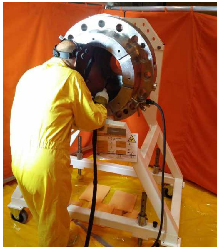
6 Svařování ucpávkového bloku HCČ
