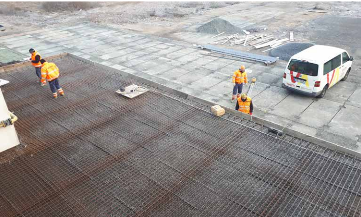
1 Pohled na realizaci betonáže úložné plochy – přemístění provozu řezárny
